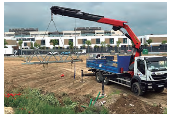
Últimas fases del desmontaje de las torres de alta tensión
