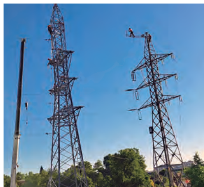
Primeros trabajos del desmontaje de las torres de alta tensión
