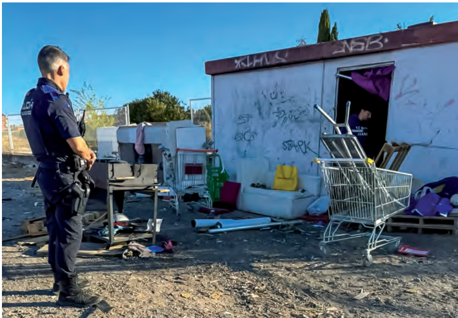
Caseta de un antiguo centro de transformación eléctrica en la calle Solana
