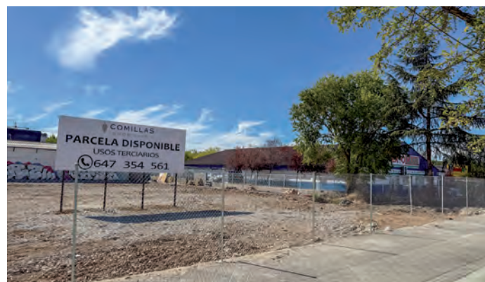
En esta parcela, situada en la Carretera de Loeches junto a una superficie comercial de gran tránsito, se encontraban dos naves abandonadas ocupadas ilegalmente que se han derribado
