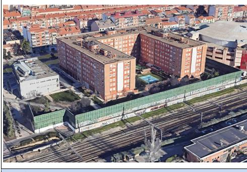
Ilustración 10. Ejemplo de pantalla acústica junto a vía ferroviaria. Torrejón de Ardoz.
