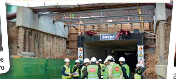
Reforma de la actual estación de tren de Plaza de España
